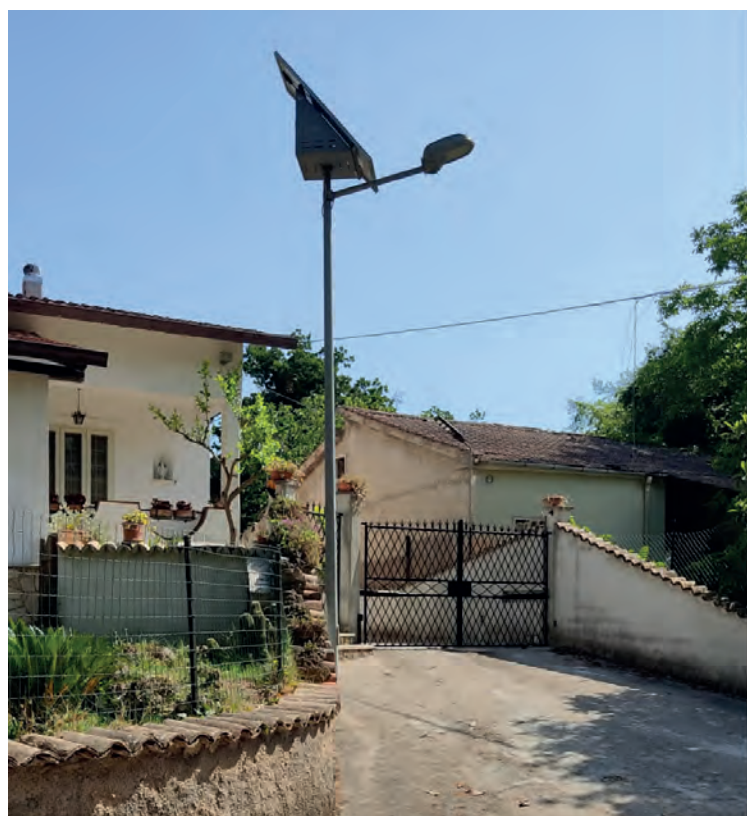
Sostituzione vecchio lampione obsoleto, con Sparky 240C1 8400 LM
