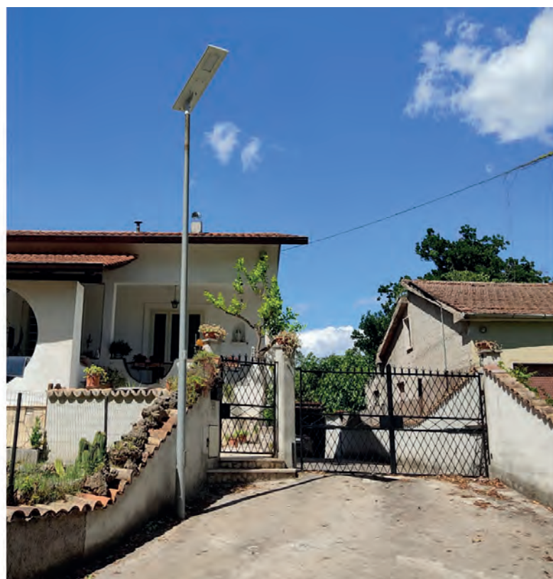
Sostituzione vecchio lampione obsoleto, con Sparky 240C1 8400 LM
